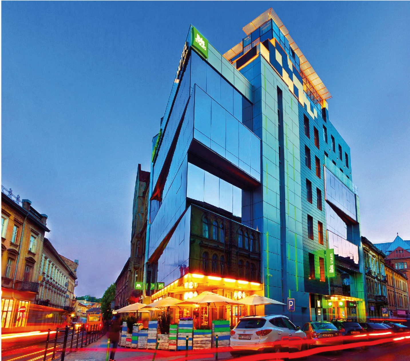
Готель «Ібіс». м.Львів, 2015рр. Профільна система Reuplers CW-50 SC (структура), країна виробник - Бельгія.
