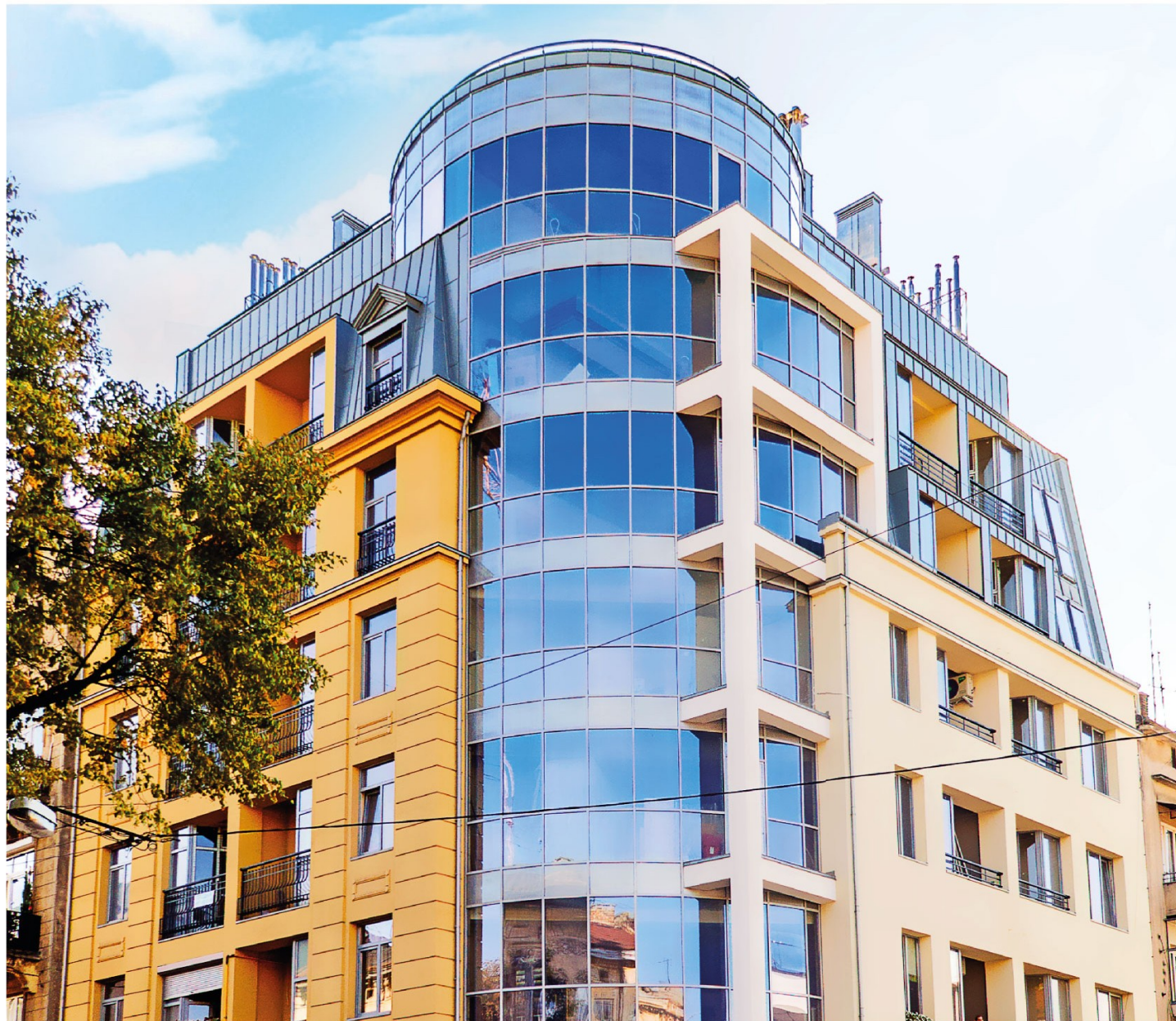
Житловий будинок з офісними приміщеннями. м.Львів, 2015рік. Профільна система Alutech F50, W62, країна виробник - Білорусія.
